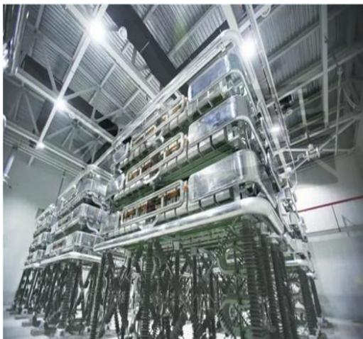
特高压多端柔性直流输电系统在多个VSC柔性换流站采用电压源型换流器，以可关断器件和脉冲宽度调制技术作为基础，在较大范围内对系统的有功和无功功率进行独立控制，实现对交、直流电压和频率的动态调节，以及向无源网络系统安全供电。此技术可以广泛应用于与交流电网同步或非同步互联、风力发电等新能源接入、向孤立无源负荷供电（海岛、钻井平台等）、以及构筑大都市直流配电网，改善电能质量和分配效率。
