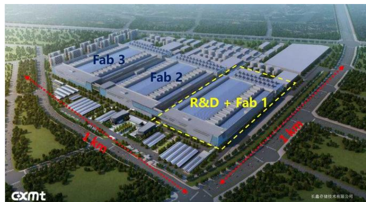
图 2： 目前长鑫已经完成 Fab1 和研发中心建设
